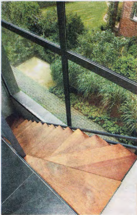
De trap is een lichte constructie van staal en hout.
